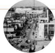
二幸屋上から工事中的コマ劇場が見える歌舞伎町街方向
